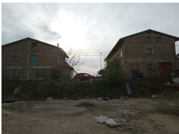
Vista verso ovest
