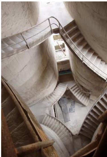
Figura 17 - Scale ai silos della cementeria Sacci
