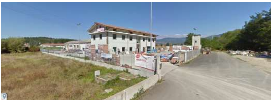
Figura 6 Immagini del fabbricato attuale al 2011
