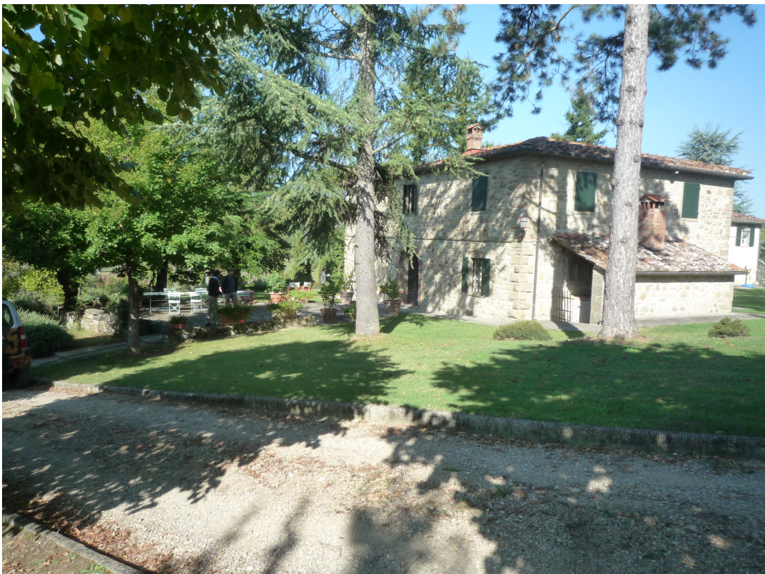
fotografia 2 – prospetto sud-ovest (in primo piano tratto di strada che verrà eliminato in virtù di quanto autorizzato con CILA n. 23516 del 24-12-2019 )
